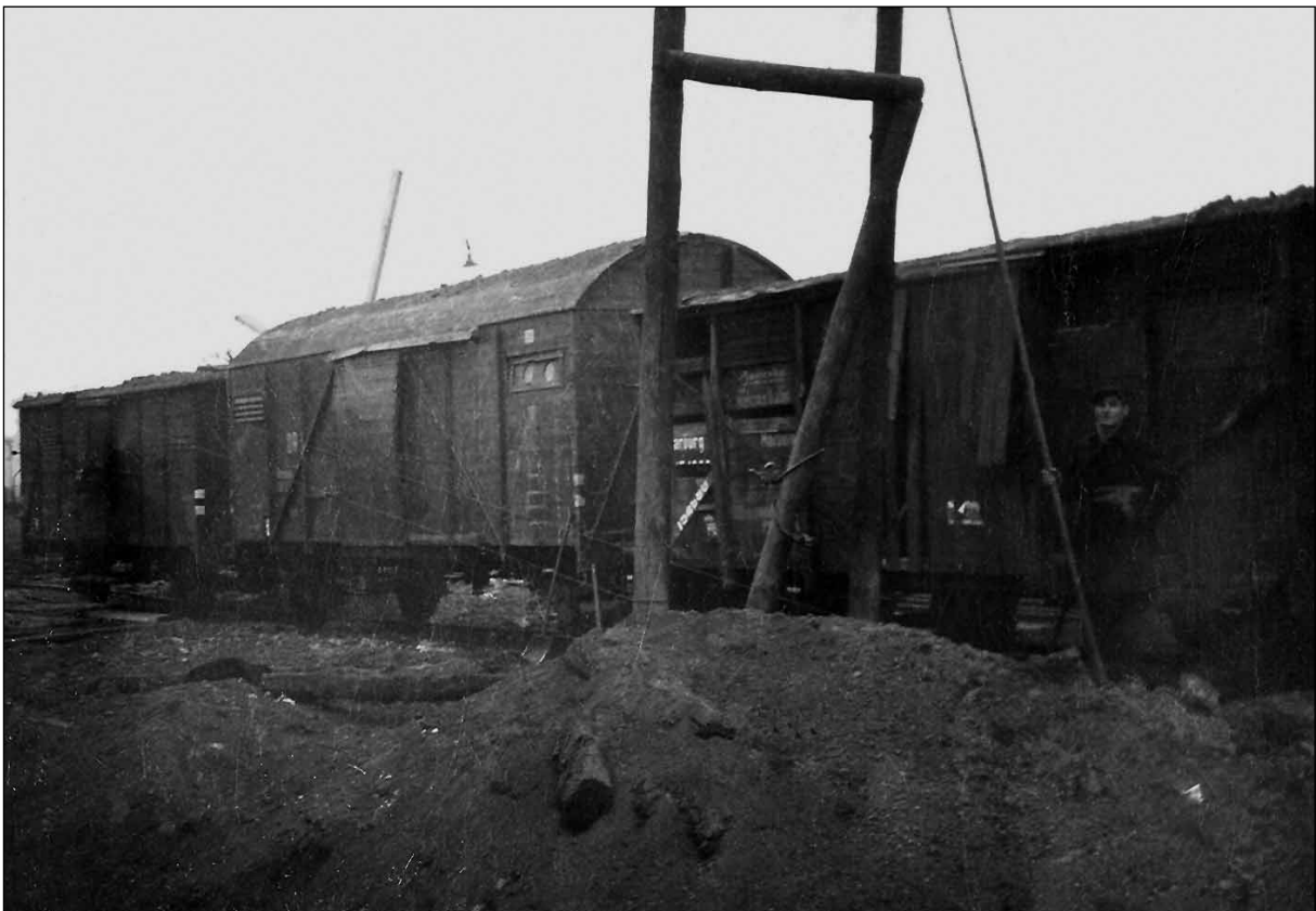
Zerstörte Waggons auf dem Abstellgleis, 20. Februar 1944
